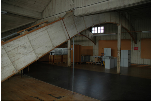
Halle 5 (Quelle: Hosoya Schaefer Architects AG)
