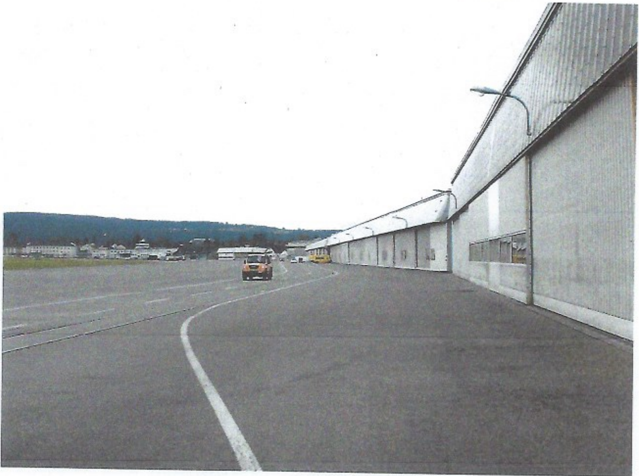
Foto 3: Sicht entlang den Flughafenwerkgebäuden am nördlichen Rand des Flughafens, Hangars bzw. Hallen 2, 3, 4 und 5.
