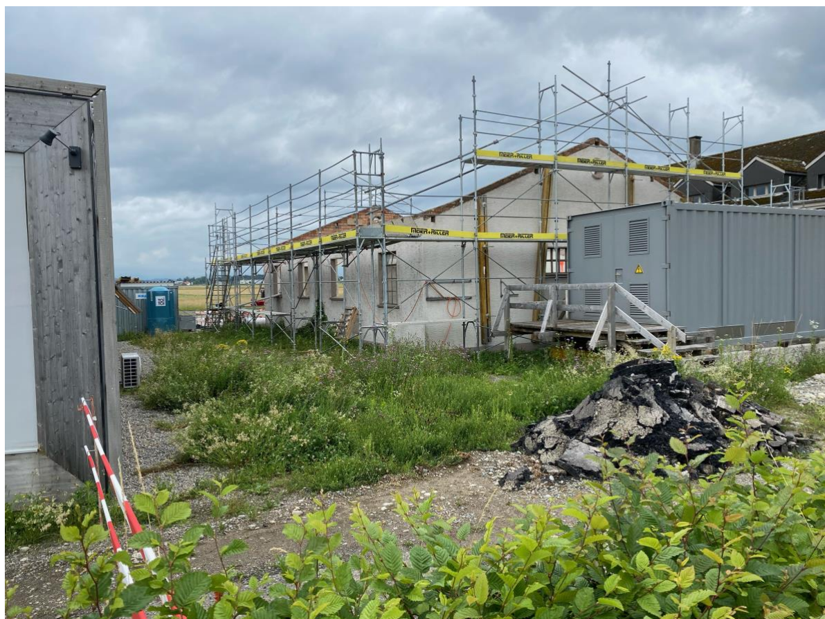
Denkmalpflege in Dübendorf
